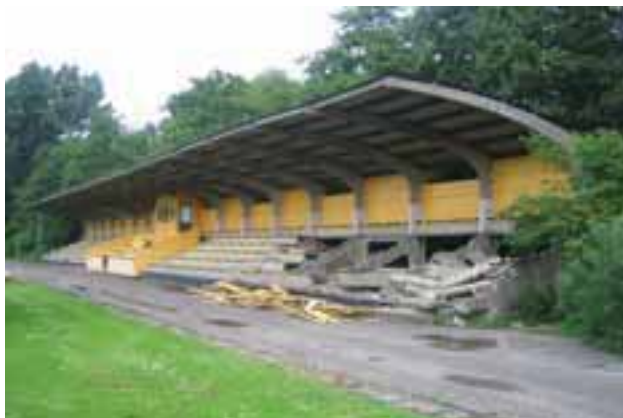
Juni 2007 het einde van een tribune. In 1958 geplaatst op het veld aan de Zuidelijke Wandelweg, mee verhuist naar Sport - park Goed Genoeg. (gesloopt i.v.m. herinrichting AFC velden).
