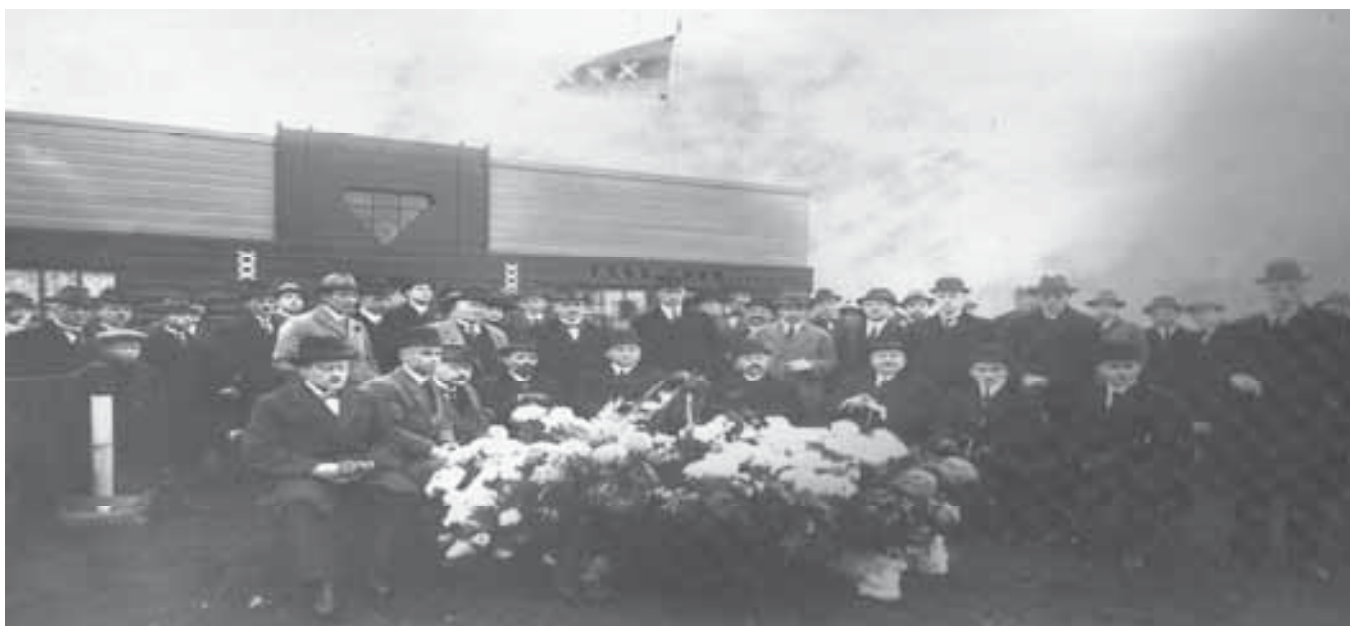
Opening van het nieuwe AFC-complex op 4 december 1920.
